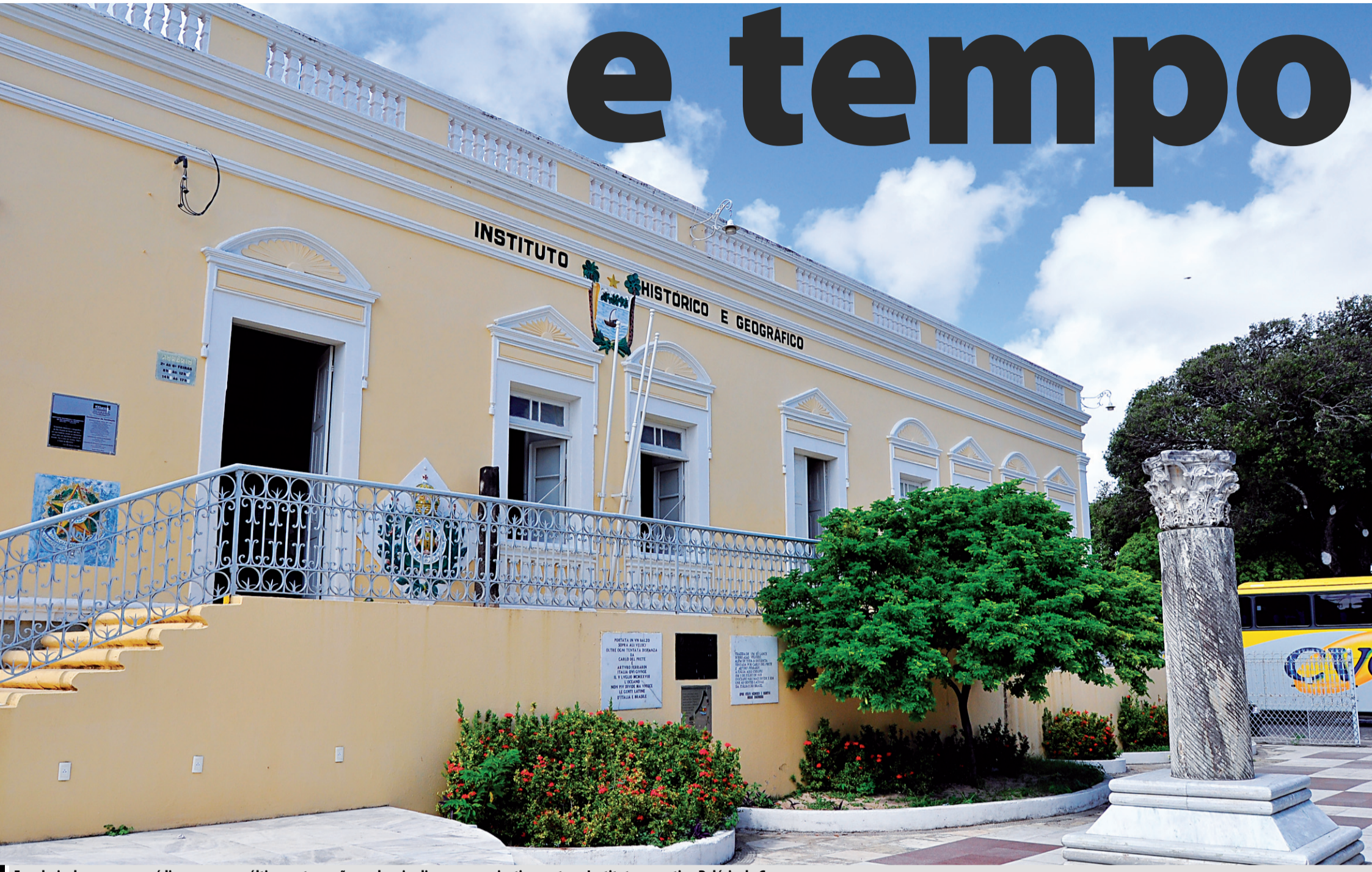
Escadaria de acesso ao prédio que em sua última restauração ganhou jardim e praça privativos entre o Instituto e o antigo Palácio do Governo
