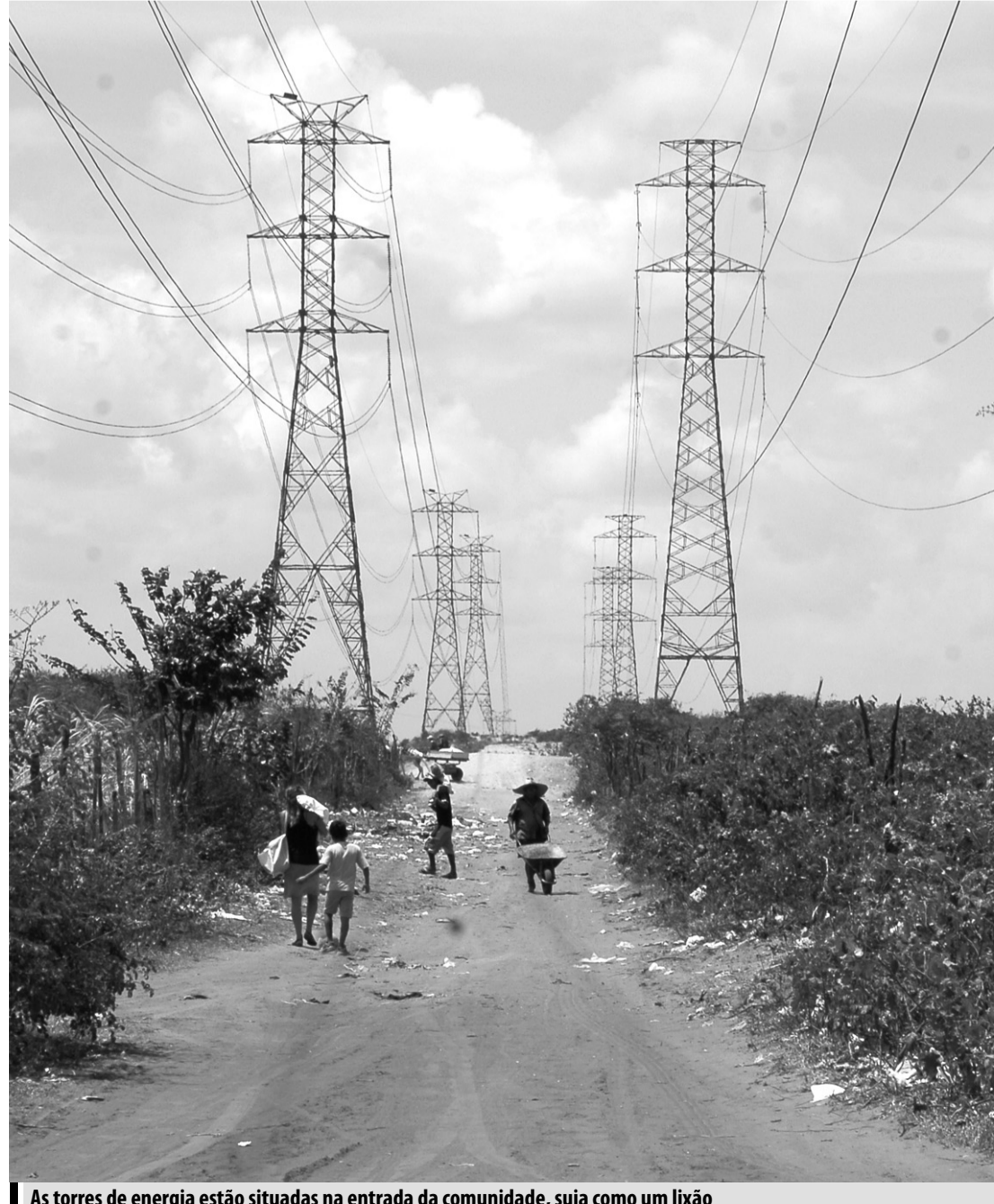
As torres de energia estão situadas na entrada da comunidade, suja como um lixão
