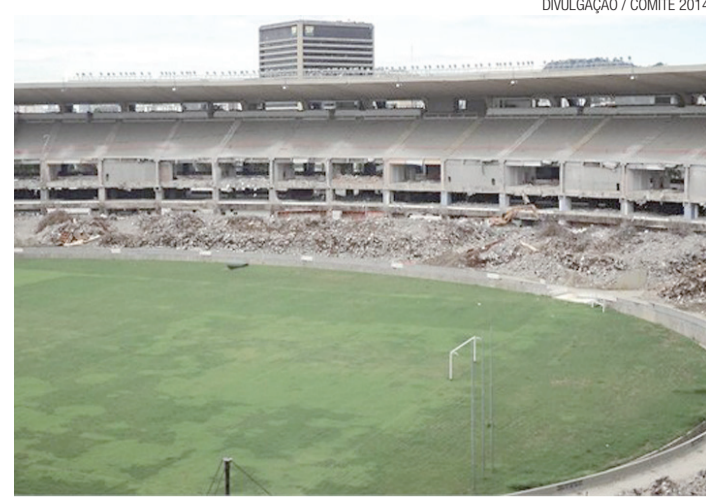
► Maracanã: tecnologia da construção civil e obras avançadas
