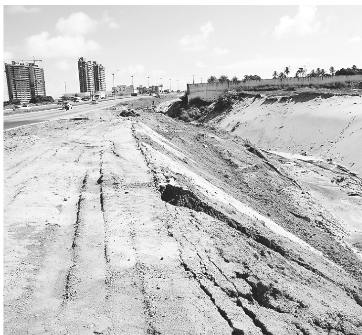
▶ Trechos da barreira construída para impedir um novo desabamento apresentam indícios de erosão e pequenas rachaduras na sua borda
