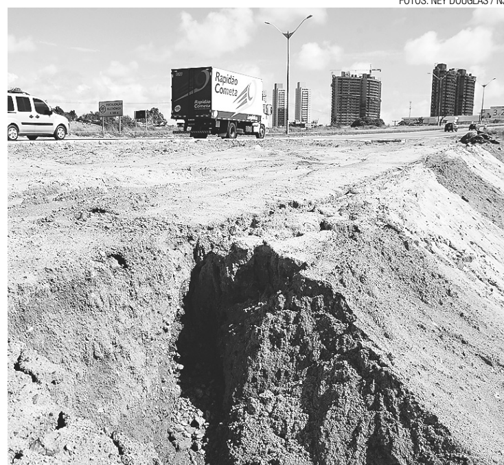
▶ Trechos da barreira construída para impedir um novo desabamento apresentam indícios de erosão e pequenas rachaduras na sua borda
