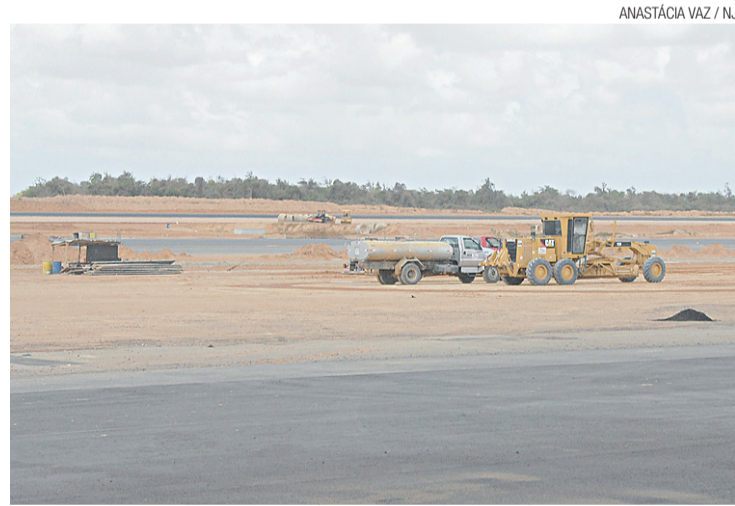
▶ Obras das pistas já consumiram R$ 250 milhões
