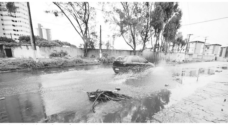
► Avenida Airton Sena: água da chuva encobre o buraco
