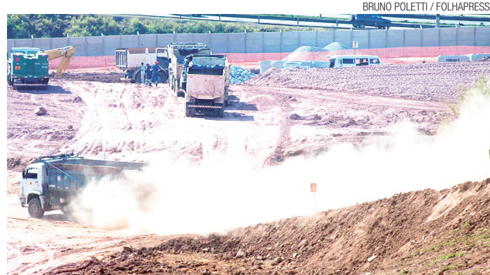
► Máquinas tocam obras do Itaquerão
