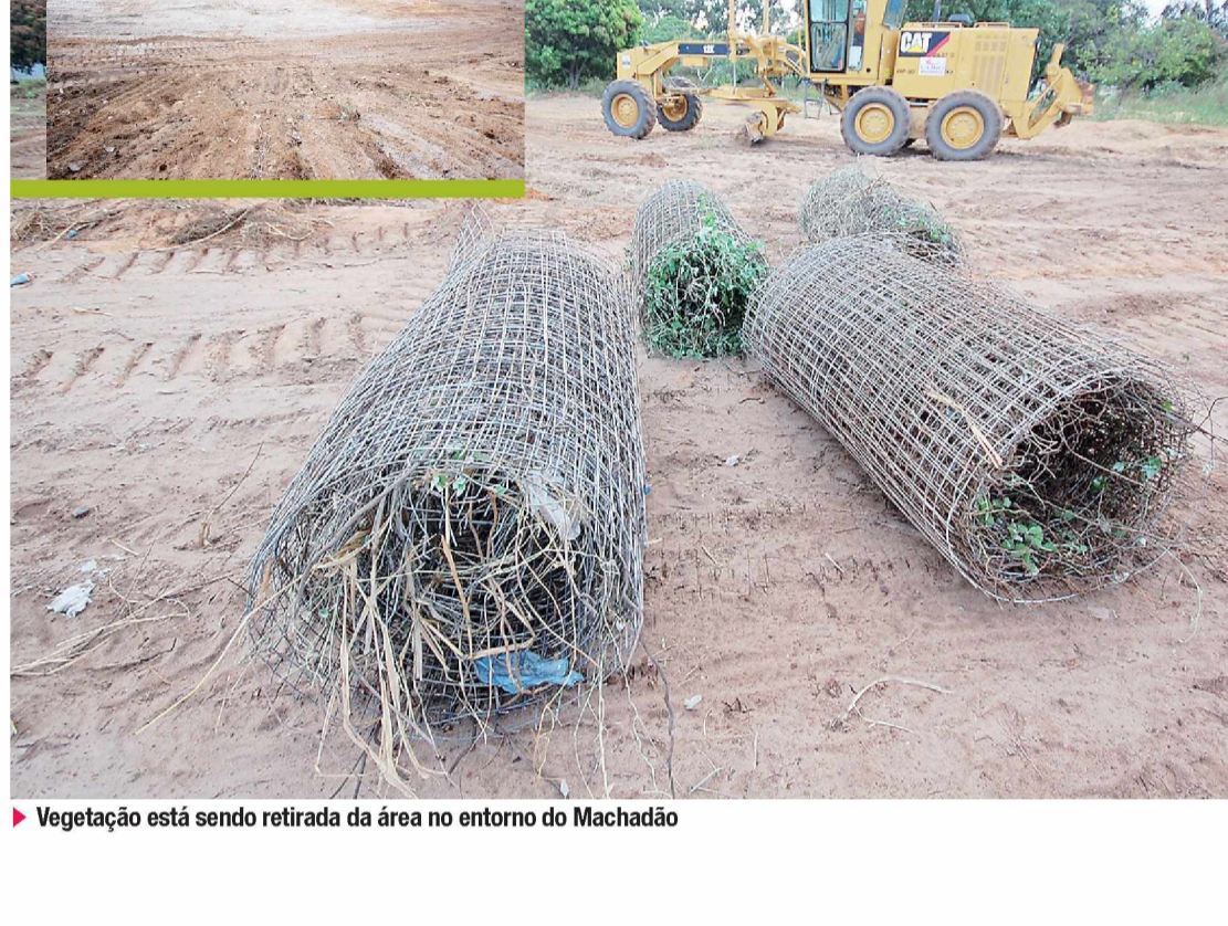
▶ Vegetação está sendo retirada da área no entorno do Machado
