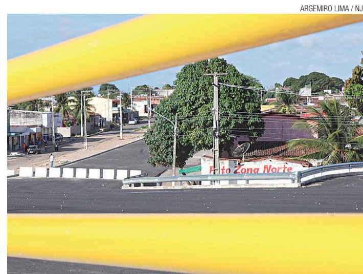
Acesso ao viaduto da Avenida das Fronteiras faz parte do Pró-Transporte
