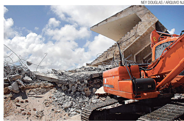
▶ Obra da Arena terá acompanhamento do Crea
