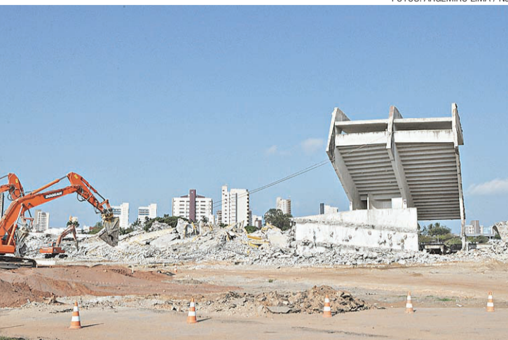
▶ Máquinas puxam cabos de aço presos ao concreto
