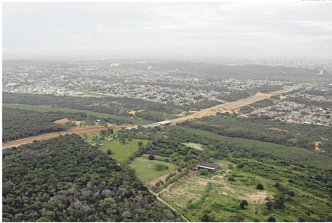
► Obra está paralisada
