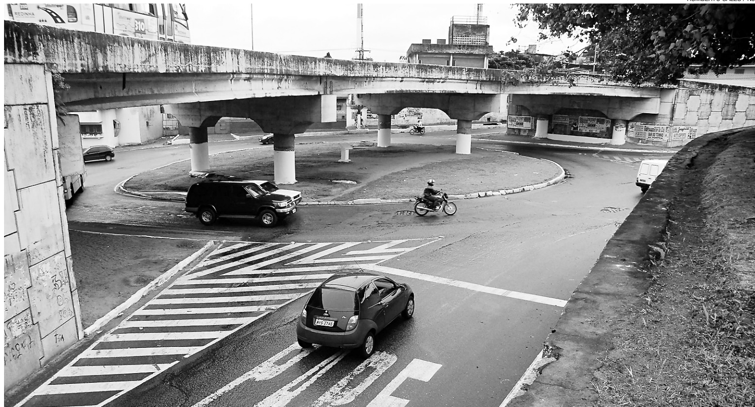
▶ Viaduto da Urbana deve inaugurar o conjunto de obras viárias previstas para Natal
