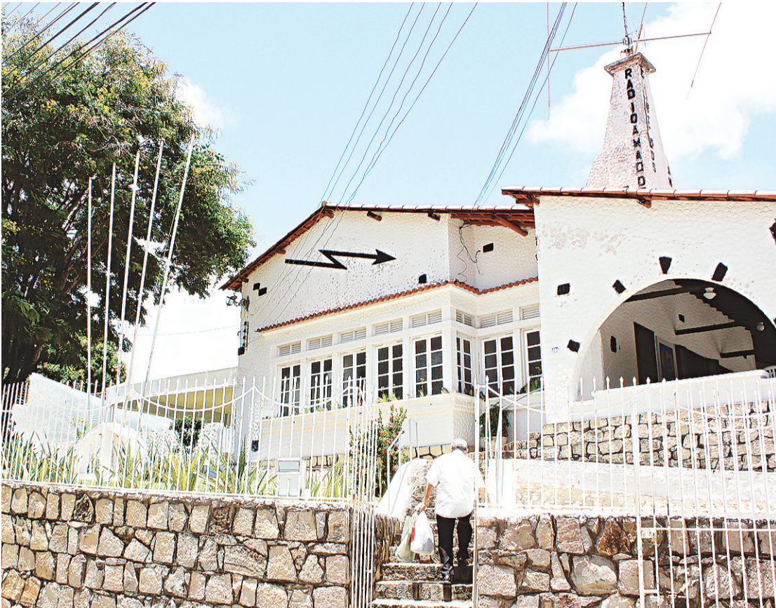
Terreno onde está instalado o Clube de Radioamadores foi doado pelo governador José Varela e não pode ser trocado
