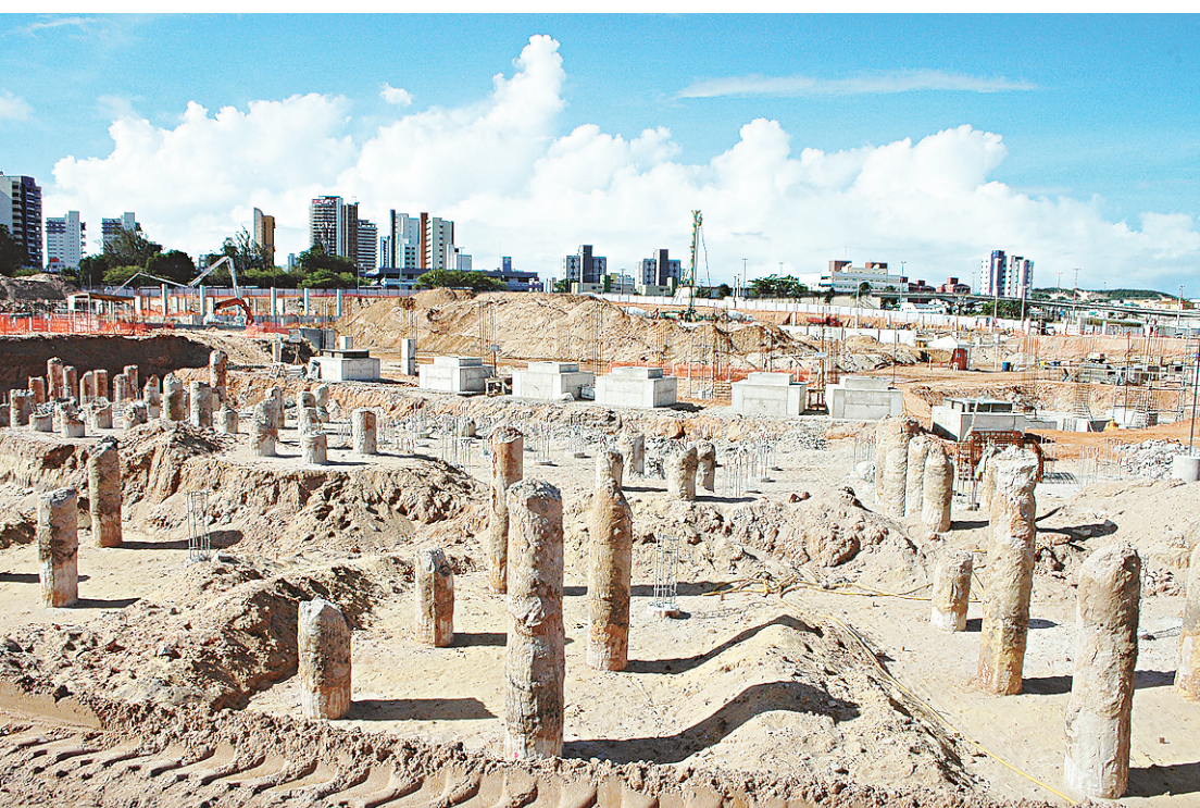
▶ Pilares já mudam cenário no canteiro de obras
