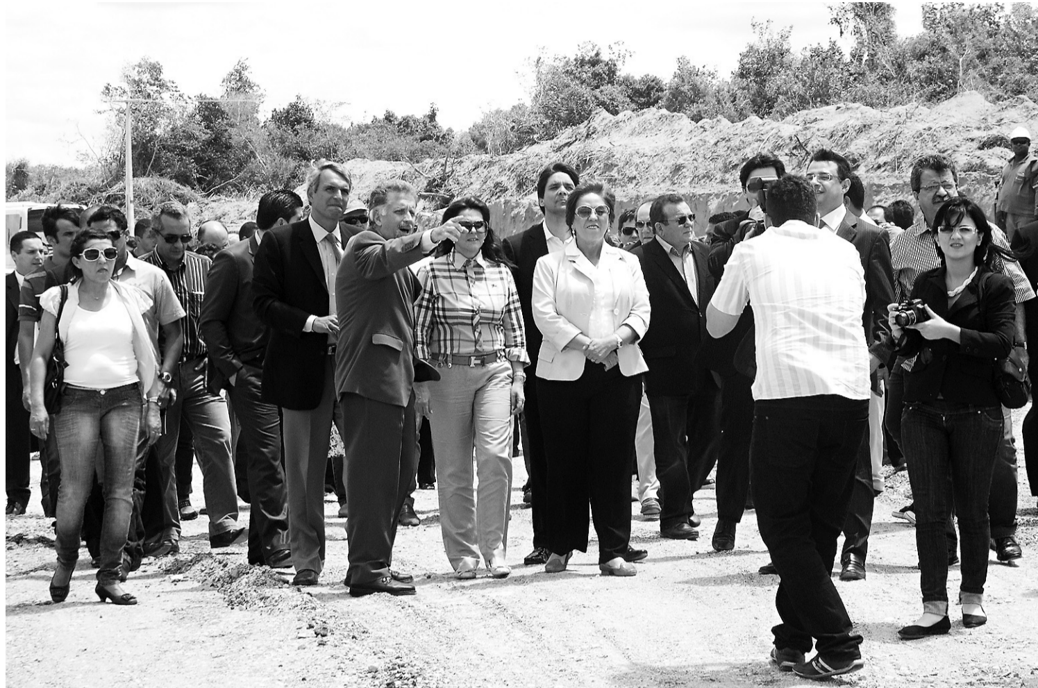
► Governadora Rosalba Ciarlini visita obras do novo aeroporto com auxiliares e diretores do Consórcio Inframérica, responsável pela execução dos serviços
