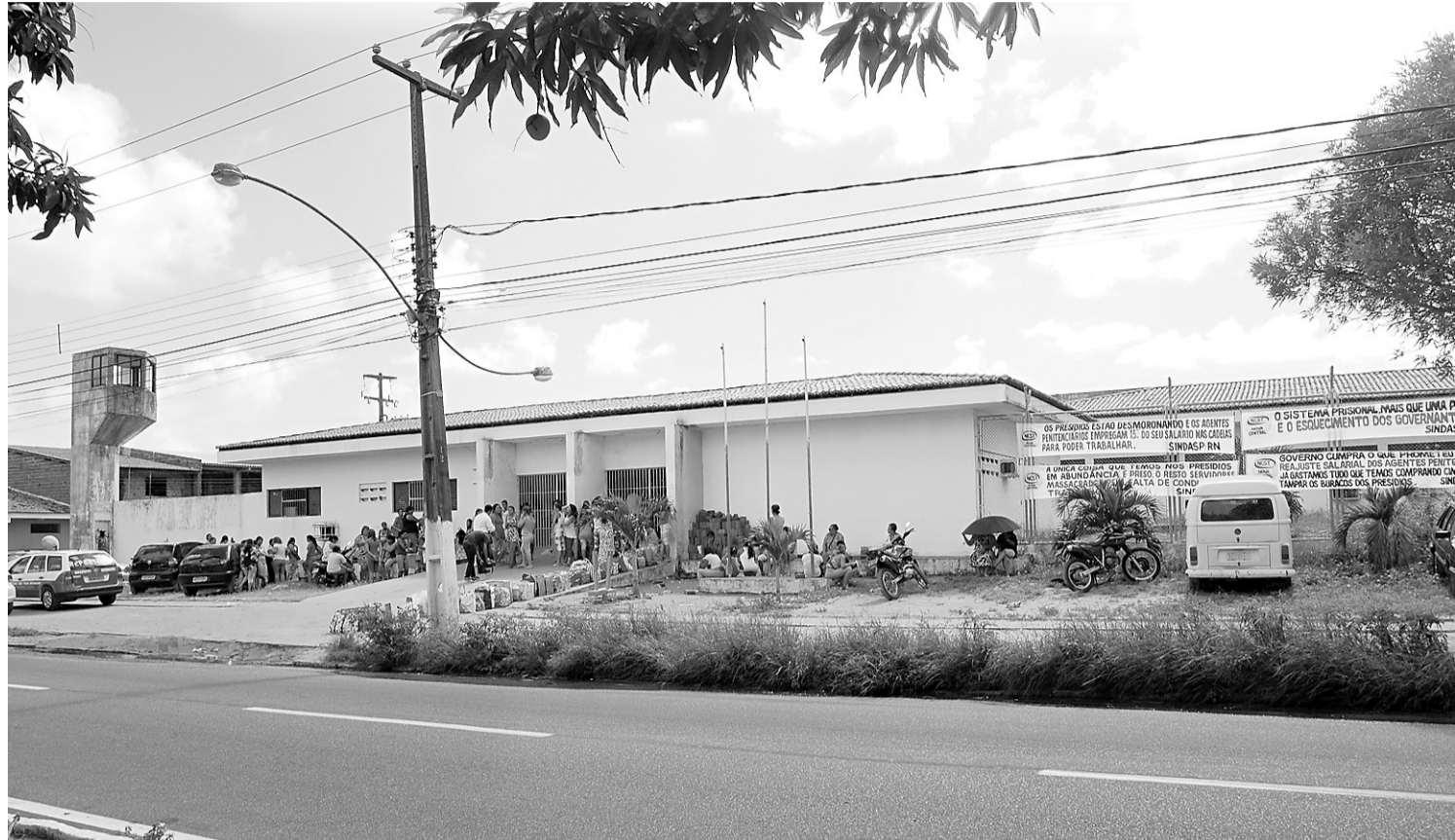
► Presídio Provisório Raimundo Nonato, na Zona Norte, está semi-destruído em virtude das revoltas, alega o juiz de Execuções Penais
