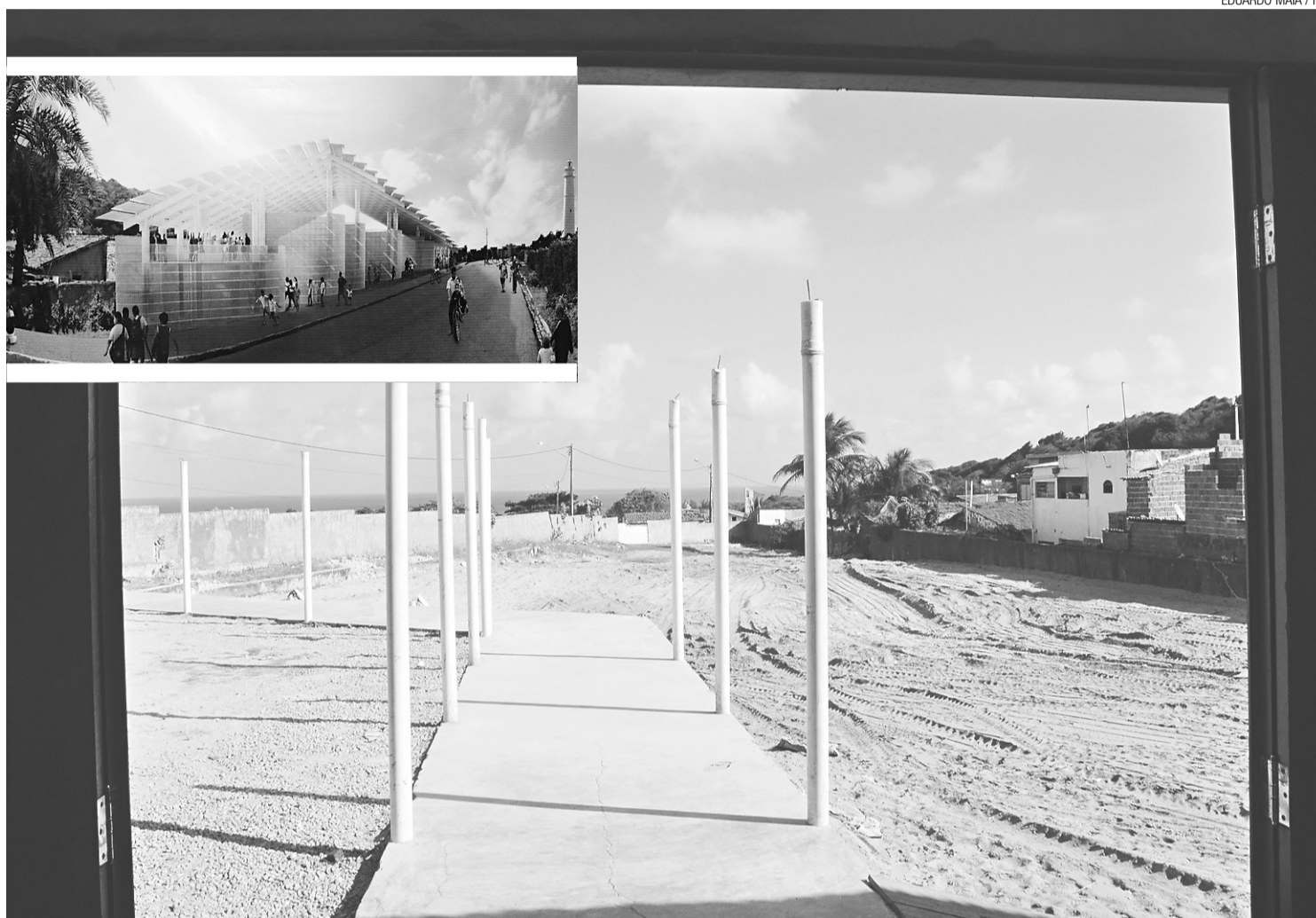
▶ Ginásio poliesportivo está sendo construído na Escola Estadual Dinarte Mariz; escritório que projetou a obra tem obras importantes pelo mundo
