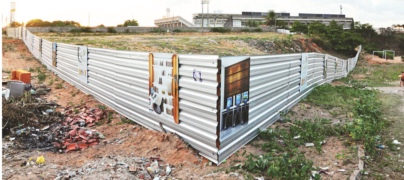
▶ Apartamentos vão integrar condomínio que será erguido em terreno permutado pelo clube
