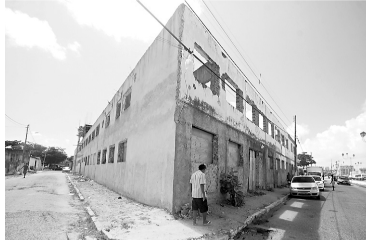
► Paralisação das obras do mercado das Rocas prejudicou município
