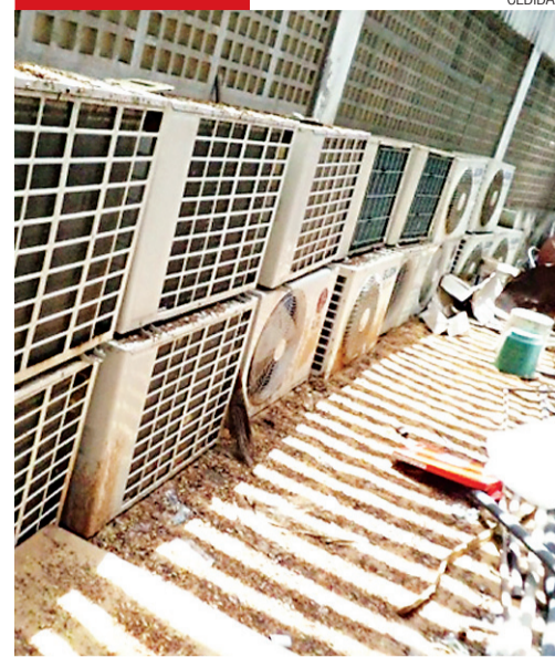
► Aparelhos de ar quebrados e empilhados na Maternidade Leide Moraes
