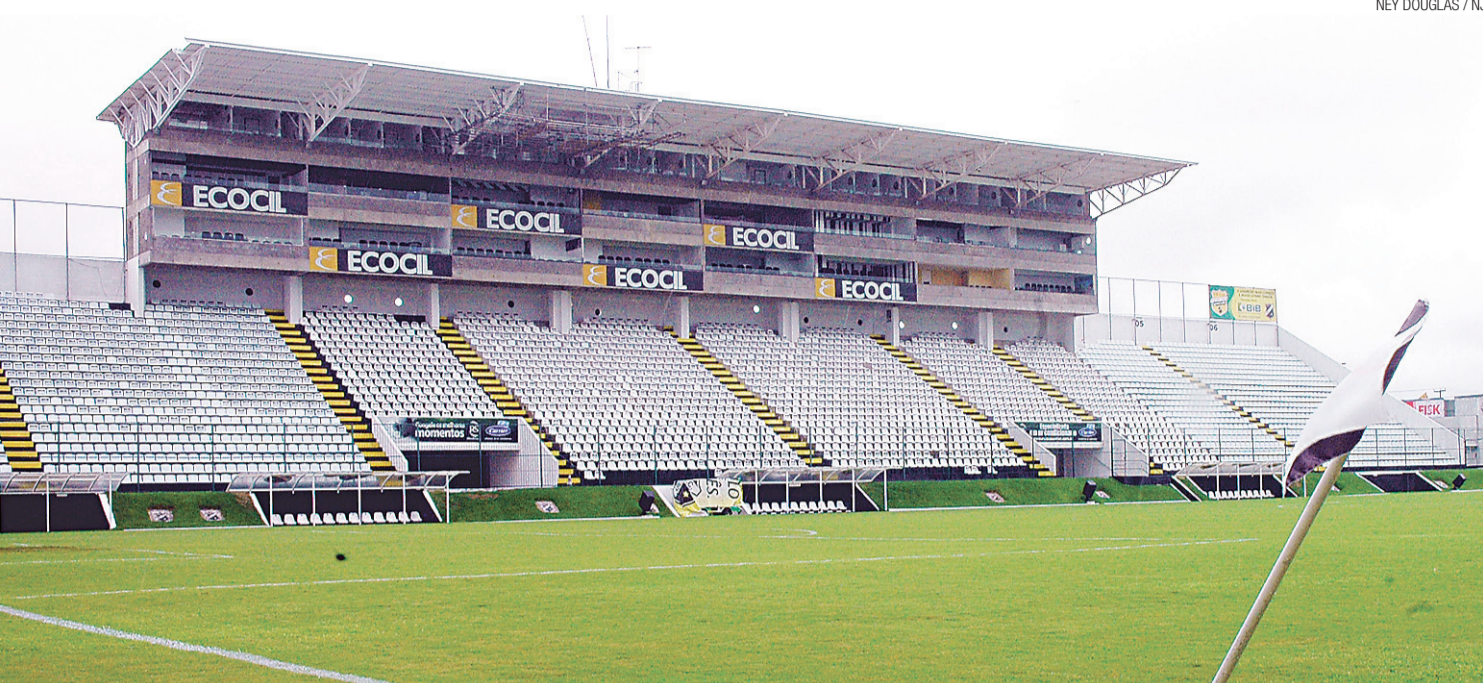
Painéis para captação e geração de energia solar serão colocados na cobertura dos camarotes. Custo será dividido entre o clube e a empresa italiana
