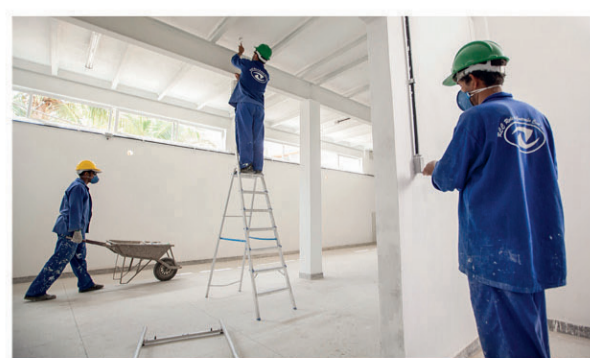
REFORMA DO HOSPITAL GISELDA TRIGUEIRO
