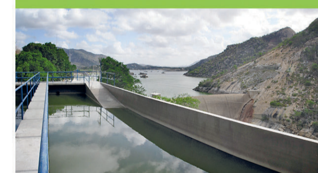
SISTEMA ADUTOR DO SERIDÓ CONCLUÍDO, BENEFICIANDO 66 MIL PESSOAS EM ACARI E CURRAIS NOVOS
