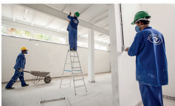
REFORMA DO HOSPITAL GISELDA TRIGUEIRO
