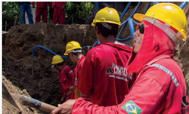
ESGOTAMENTO SANITÁRIO TIBAU DO SUL
