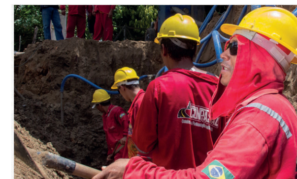
ESGOTAMENTO SANITÁRIO TIBAU DO SUL
