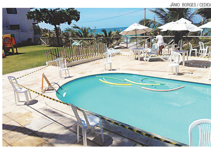
► Piscina interditada pelo Corpo de Bombeiros
