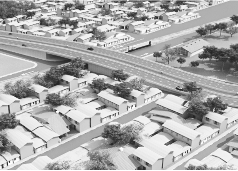
▶ Trânsito na Av. Capitão Mor Gouveia deixa de ser interrompido para a passagem do trem com a construção de um elevado
