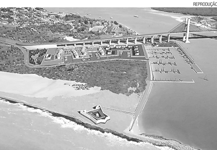
► Investimento para execução do projeto será de R$ 120 milhões
