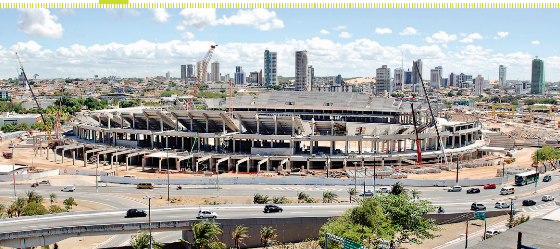
▶ Após instalação da cobertura, estádio ganhará "corpo" e se aproximará da fase final de obras
