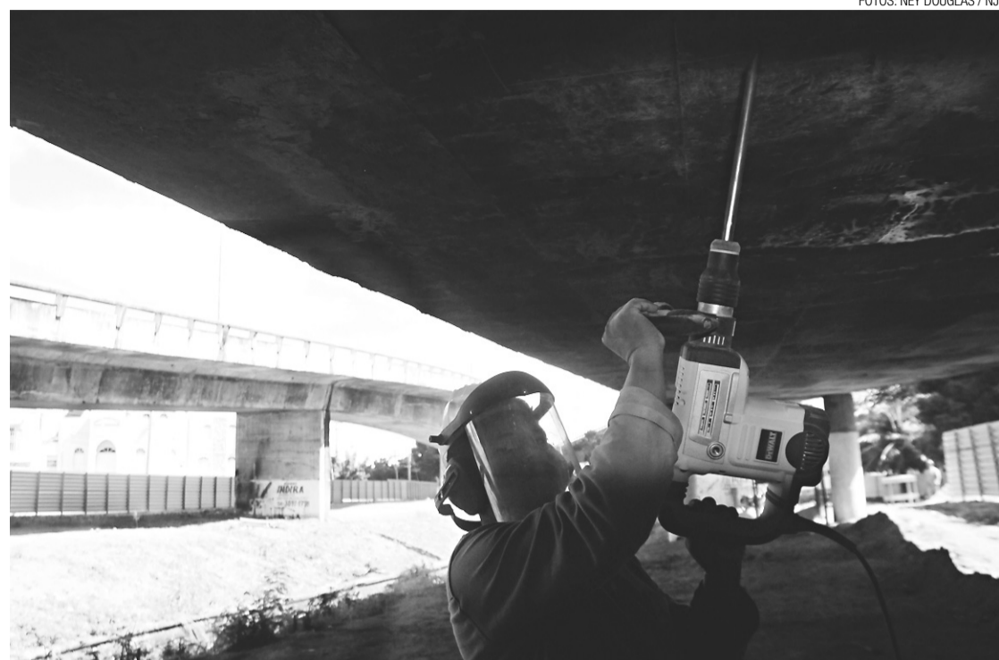
Operários iniciaram o serviço picotando o concreto nos espaços com a ferrugem exposta
