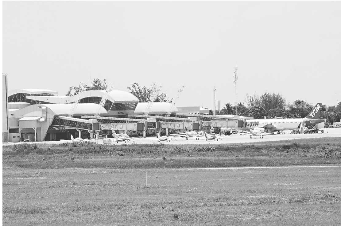
► Com quatro pontes de embarque, Aeroporto Augusto Severo tem redução de voos e de passageiros
