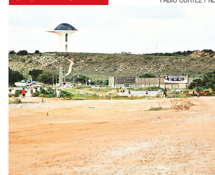
► Provável corredor da folia ainda em obras
