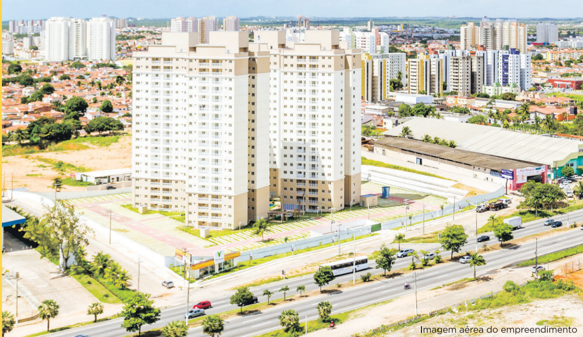
Imagem aérea do empreendimento
