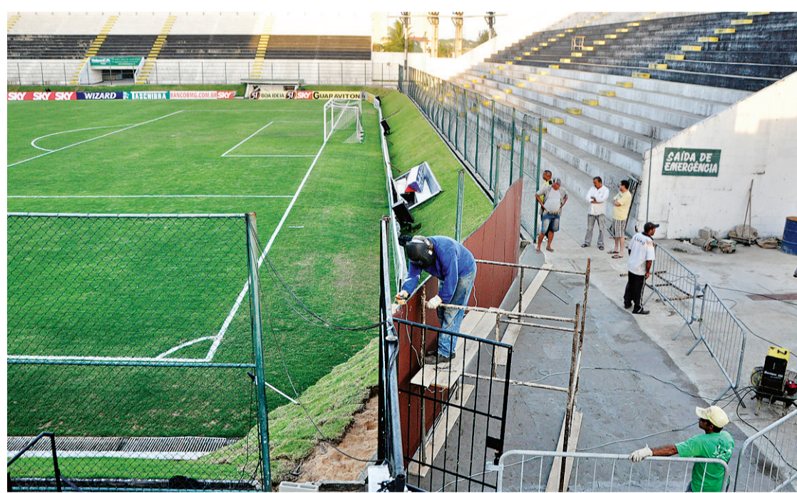
► Setor onde houve tumulto foi reformado, alargando o corredor na entrada do portão C
