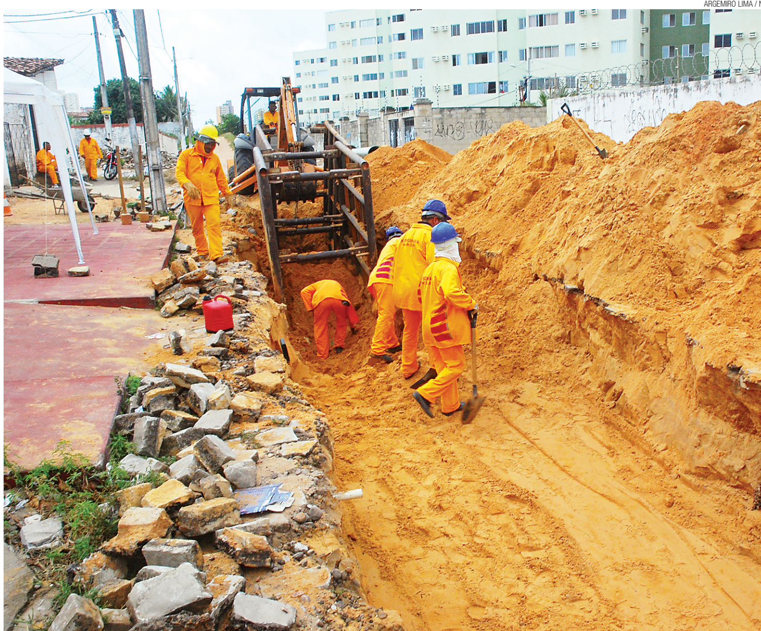
► Obras de saneamento em execução na Rua Poços de Caldas, em Neópolis
