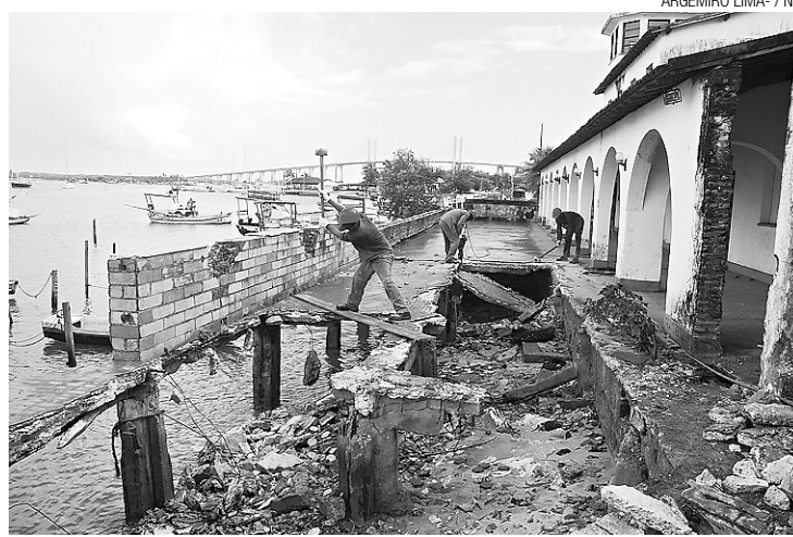
Obras na antiga Rampa vão dar lugar a centro cultural moderno
