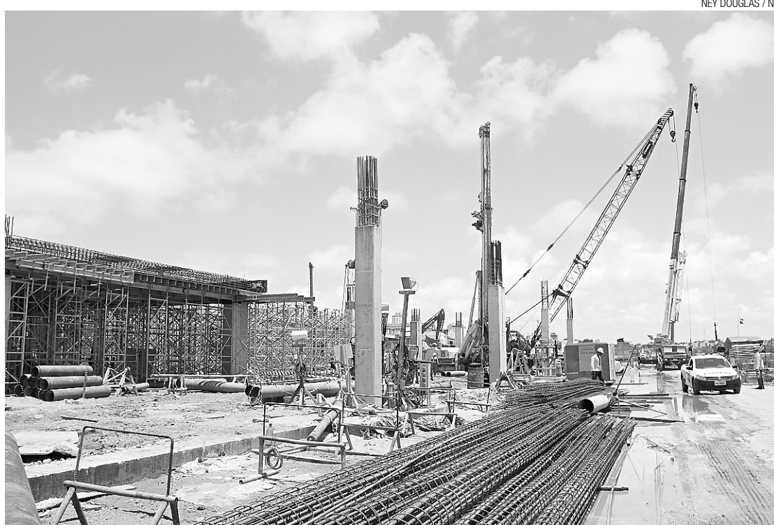
Terminal de passageiros da Ribeira é uma das obras em andamento no bairro
