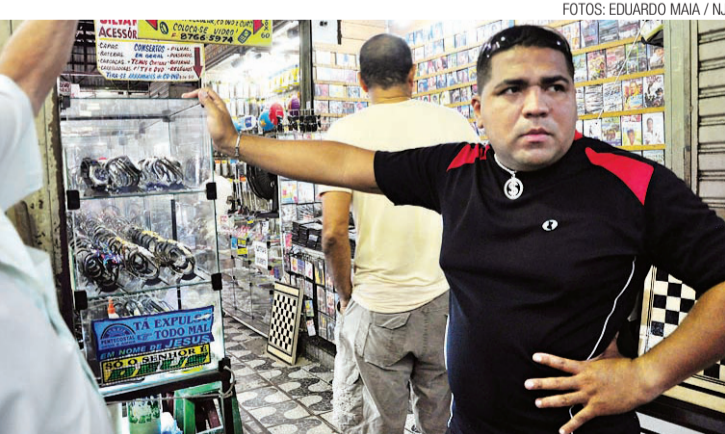
Édison Florenço, ambulante: remendos para evitar a queda da estrutura
