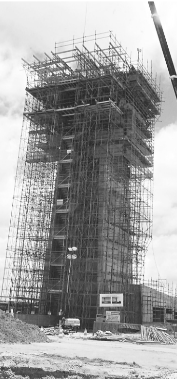
► Torre de controle do aeroporto é estrutura mais avançada: 58% pronta
