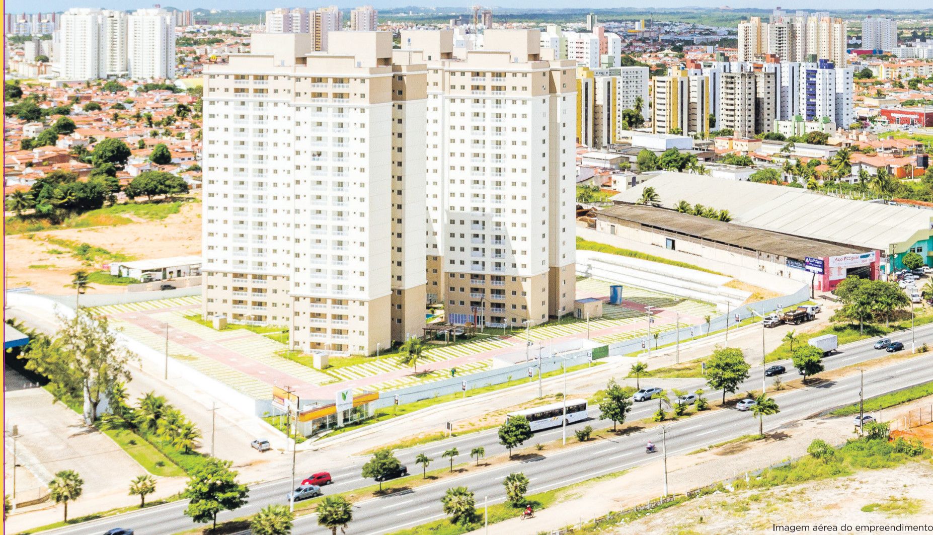
Imagem aérea do empreendimento
