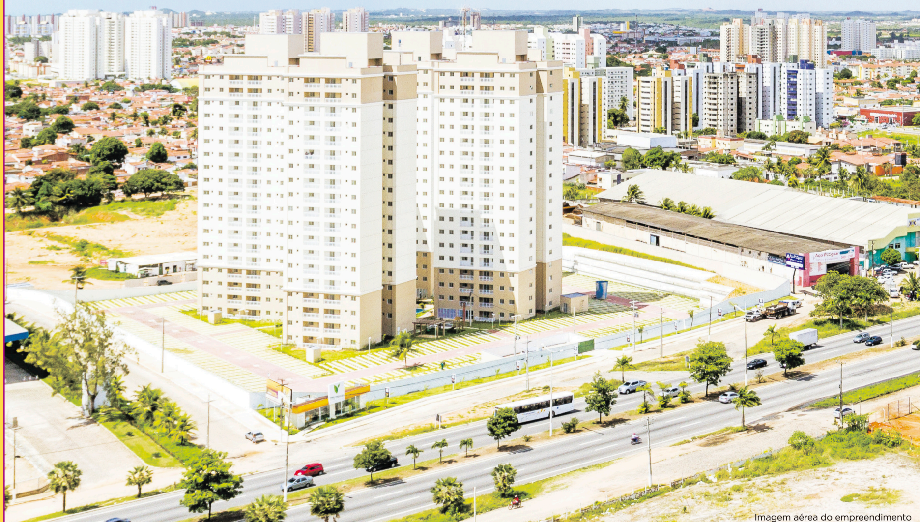
Imagem aérea do empreendimento
