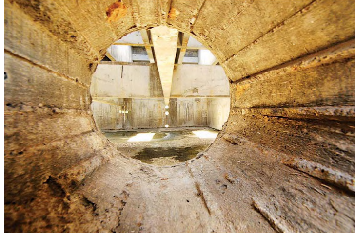
▶ Caern vai reformar antiga estação de tratamento na Redinha
