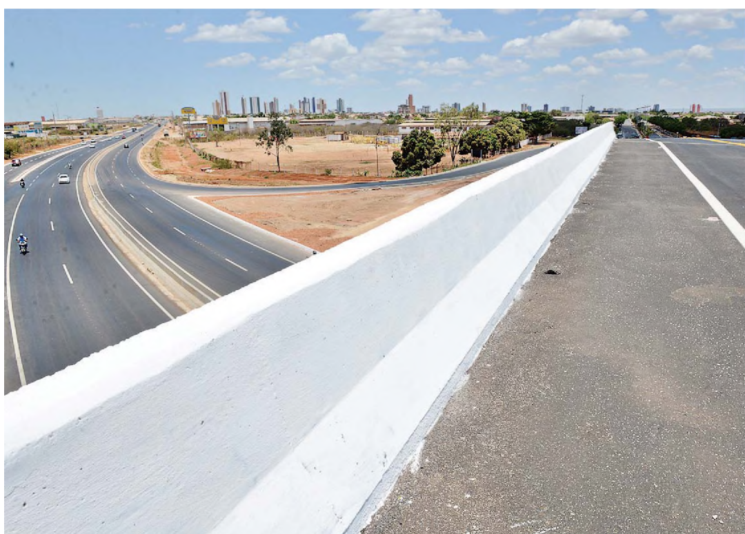
▶ Viaduto 4 foi liberado para tráfego e já está servindo à população
