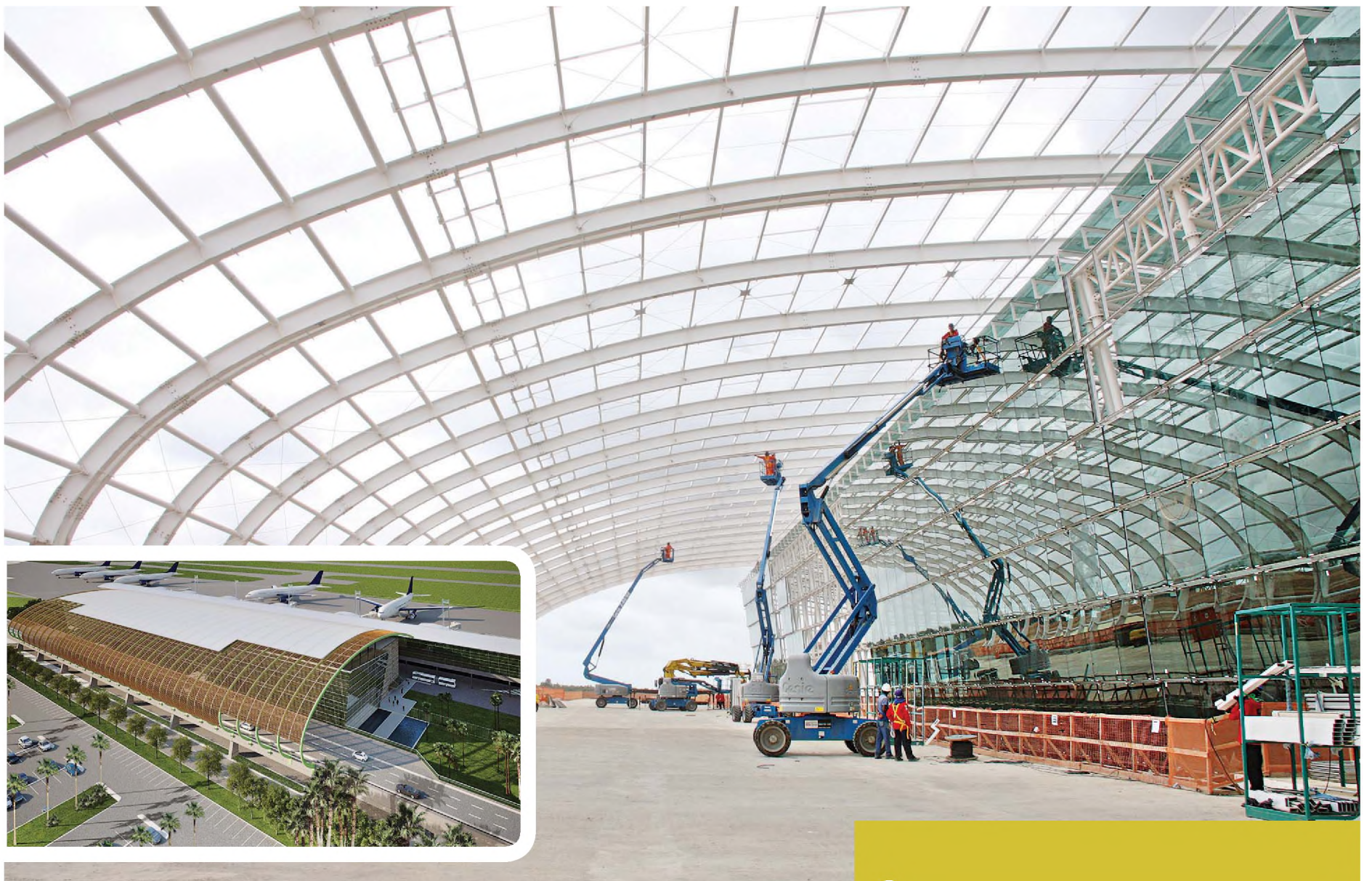
▶ Na imagem, como a obra está; no detalhe, como ficará, em 2014, quando for concluída
