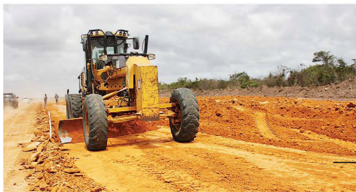
▶ Obras no acesso Norte (BR-406) estão 15% realizadas
