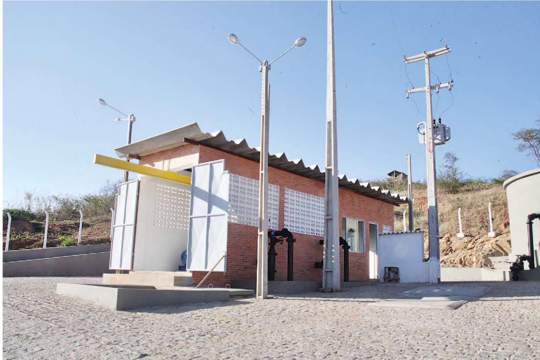
▶ Adutora em Luís Gomes substituiu o abastecimento feito por carros-pipa
