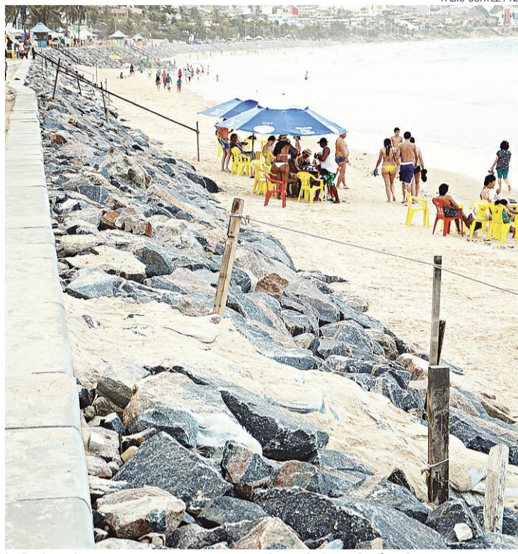
► Pedras do enrocamento representam risco ainda maior à noite
