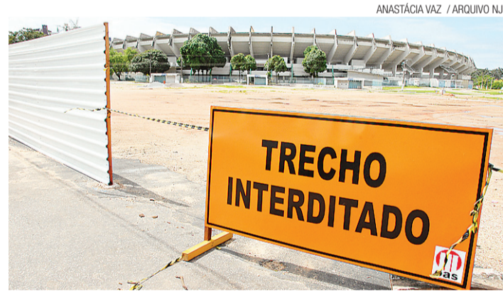
▶ Estádio Machadão é cercado para demolição
