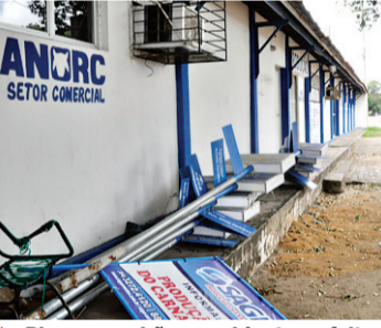
► Placas no chão e ambientes e falta de manutenção: funcionários em férias coletivas
