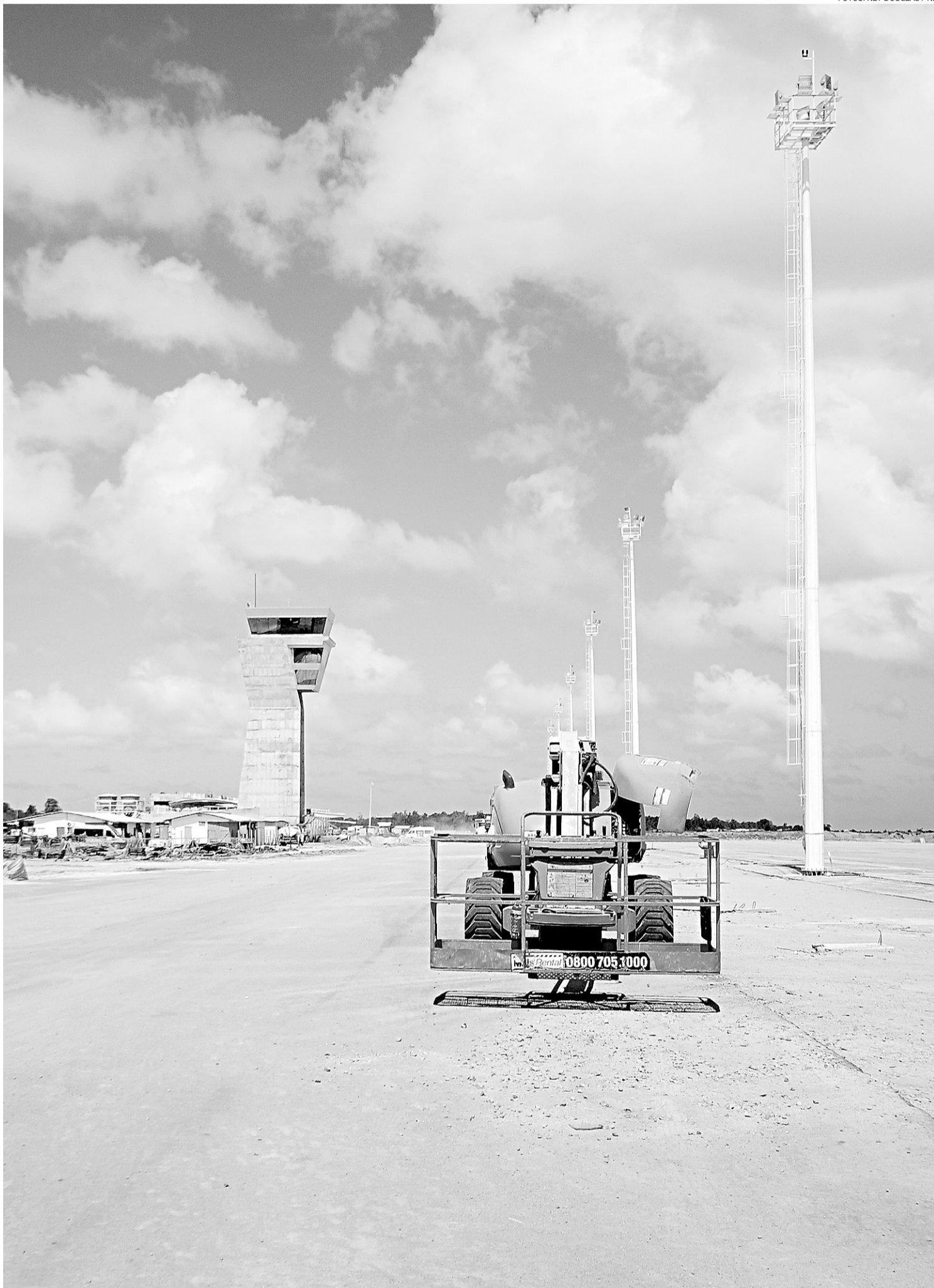
► Torre de operações do Aeroporto Aluízio Alves: “lado ar” já foi aprovado pela Agência Nacional de Aviação Civil
