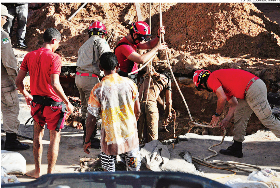
► Bombeiros resgatam corpo do servente Josias Soares da Silva, morto durante obra para a Semopi
