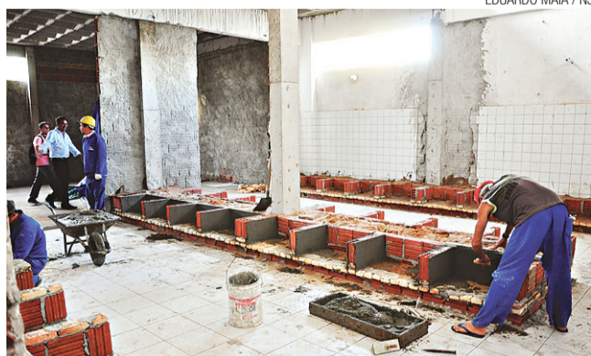
► Operários ainda trabalham no vestiário do estádio do ABC
