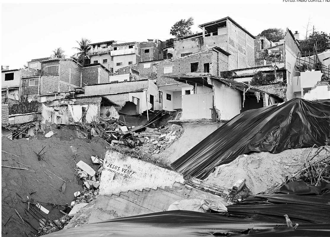
► Muro de contenção será construído na altura do aterro feito no local
