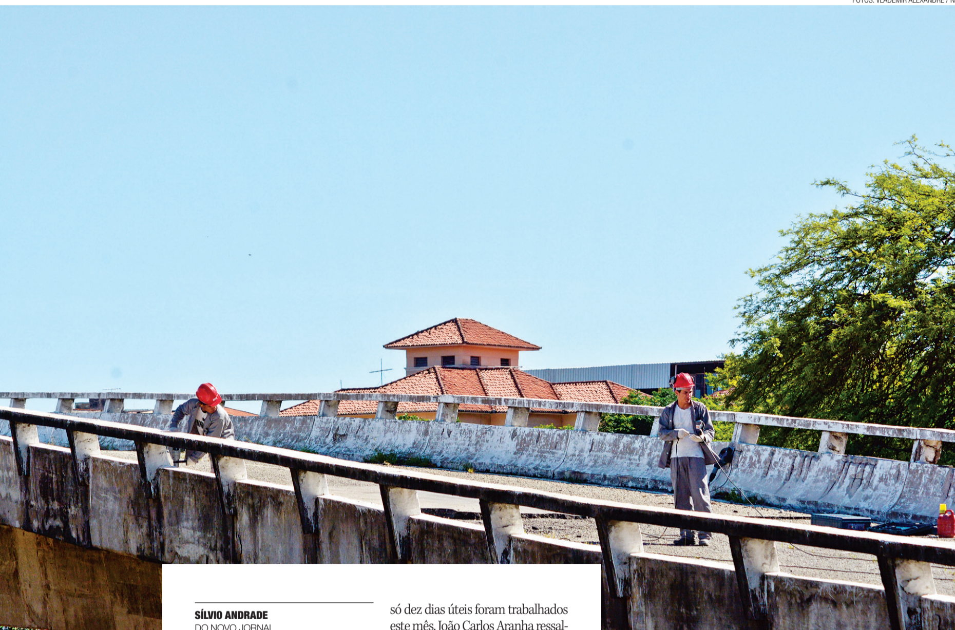
Operários trabalhavam ontem na fabricação das peças metálicas
