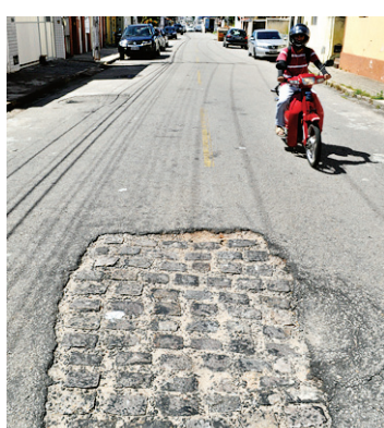
Rua Segundo Wanderley, próxima a Jaguarari, no Bairro Vermelho. Sem sinalização, o buraco revestido com calçamento, mas sem o recapeamento asfáltico, preocupa os moradores da região, que botam a culpa na Caern. “Nós vemos a hora acontecer um acidente aqui, porque os carros só veem quando já está bem próximo e têm que desviar”, afirmou o funcionário Público, Walter Barreto.
