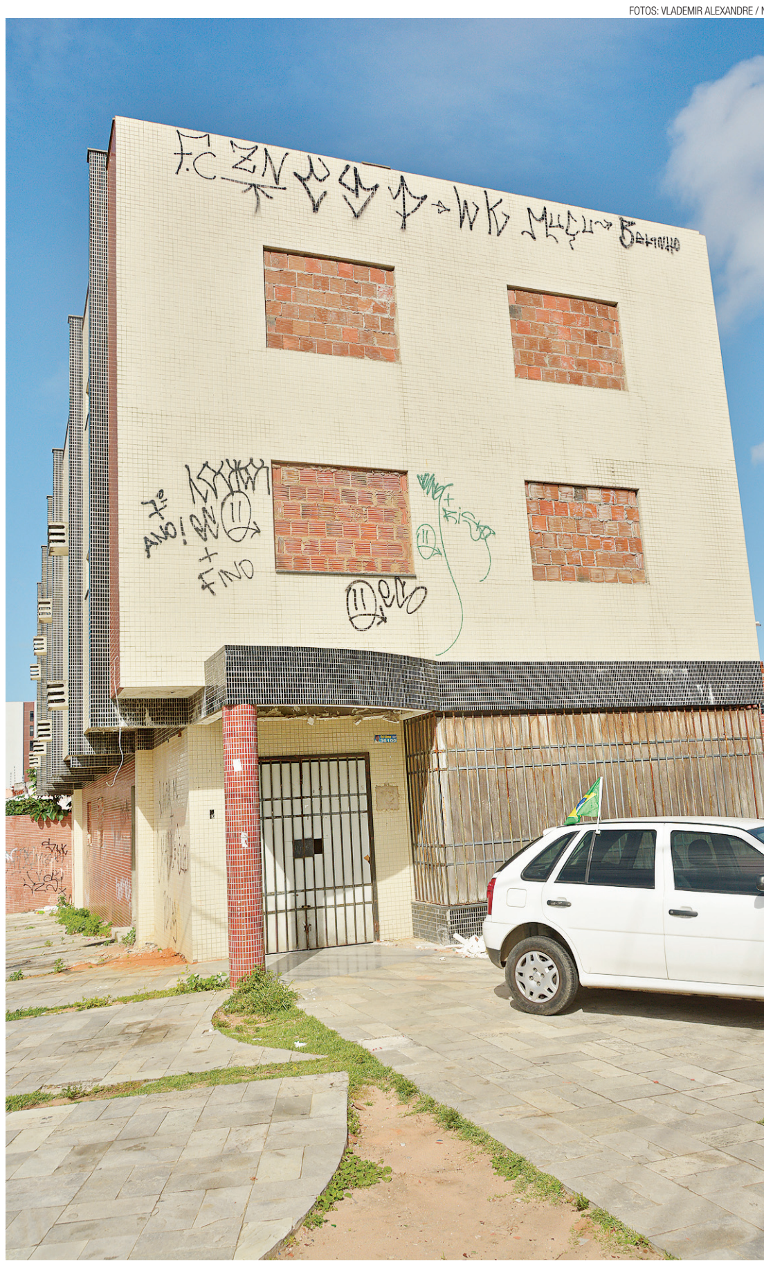
FOTOS: VLADEMIR ALEXANDRE / N.J. ▶ Edifício continua abandonado e deve agora ser transformado em arquivo, ao custo mínimo de mais R$ 427 mil
