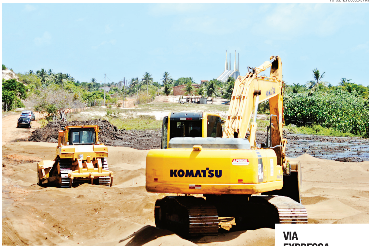
▶ Obras do Pró-Transporte na Avenida Conselheiro Tristão, Zona Norte da cidade
