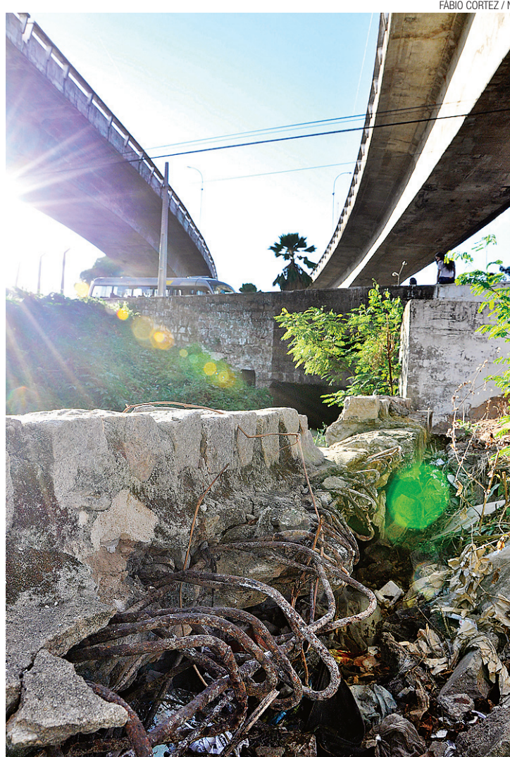
▶ Reforma deveria ter sido concluída no início deste mês
