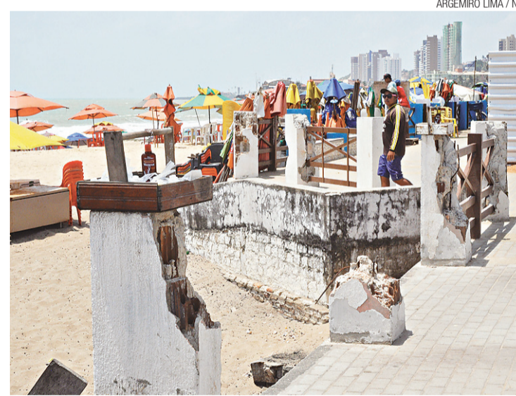
Na Praia do Meio o atraso é maior, com vários equipamentos deteriorados
