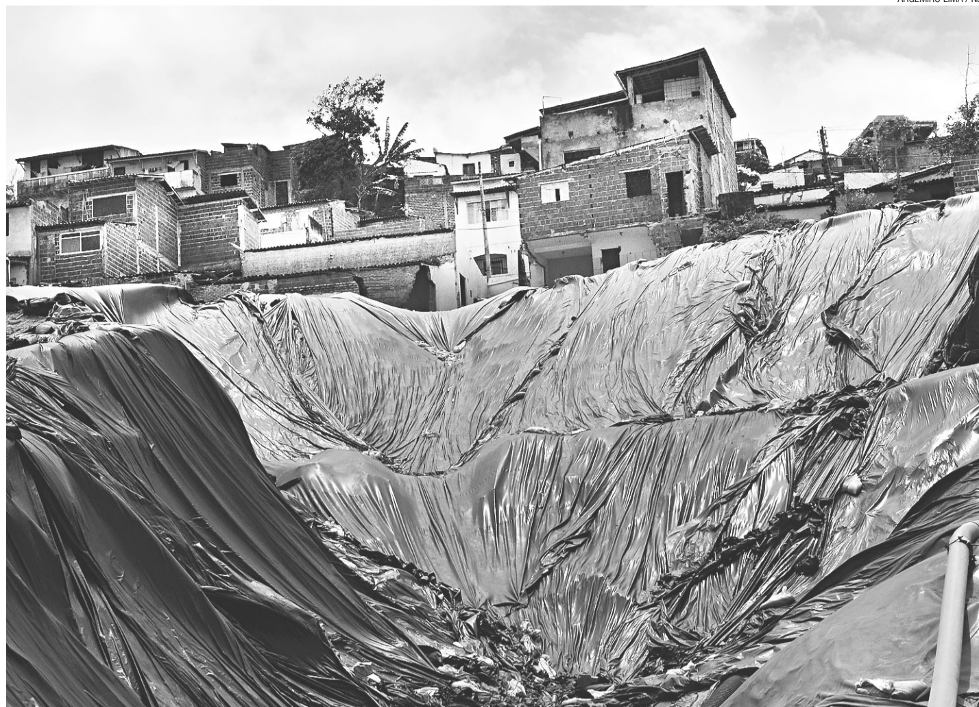
▶ Cratera aberta em Mãe Luiza continua coberta por lonas pretas, que têm o objetivo de proteger a areia de deslizamentos no caso de novas chuvas
