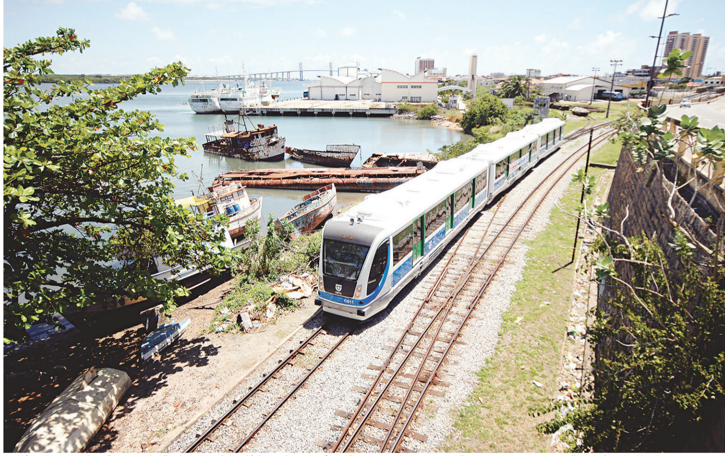
► Além da modernização e ampliação da malha ferroviária, projeto prevê a reforma de 26 e a construção de quatro novas estações na Grande Natal
