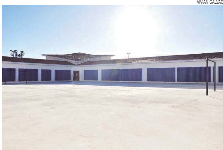
► Reforma do Pavilhão 2 de Alcaçuz foi entregue na última semana; no mês passado, as obras do Pavilhão 4 foram concluídas
