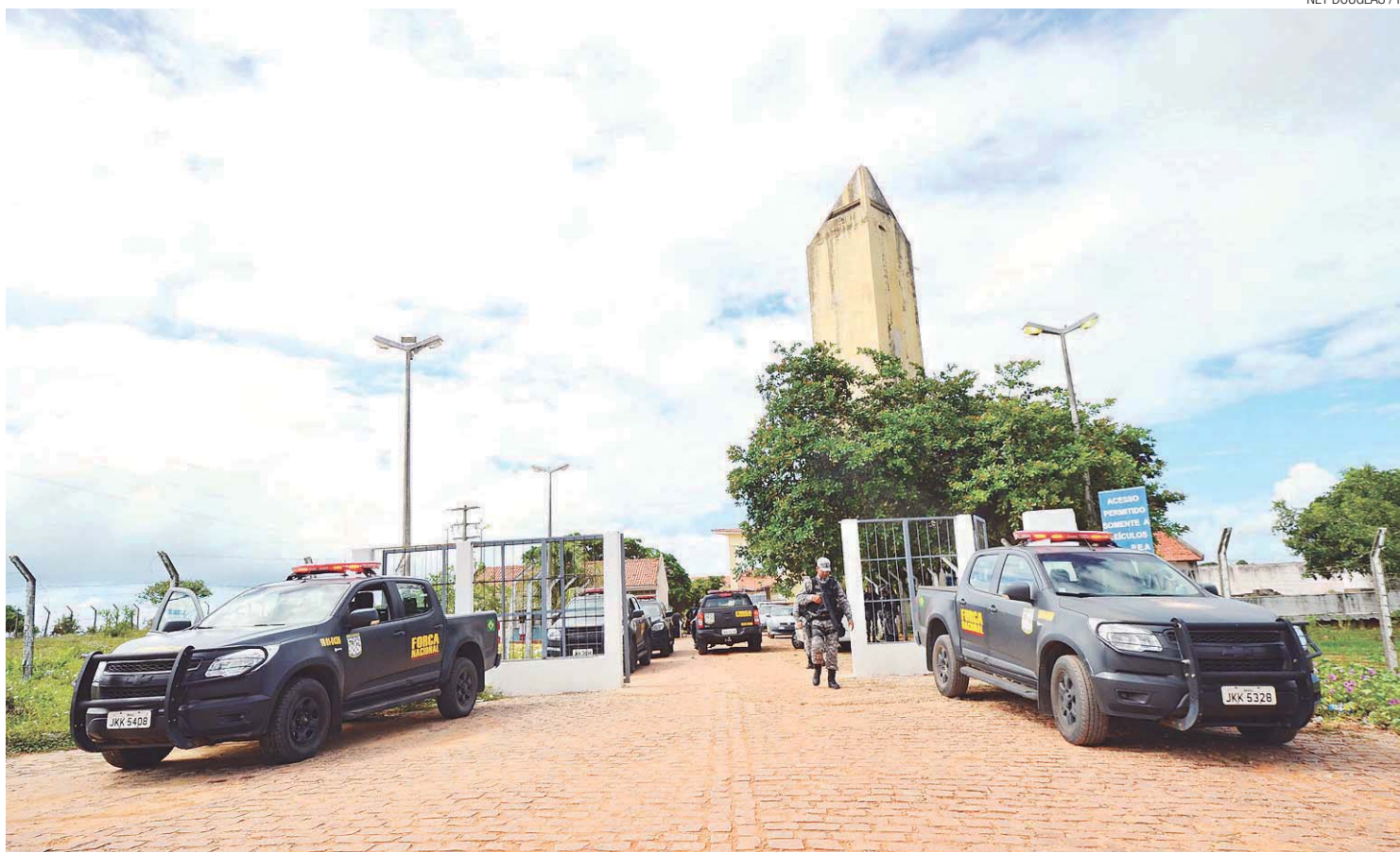
► Penitenciária Estadual de Alcaçuz, em Nísia Floresta, a maior unidade do sistema prisional do RN: também em reforma
