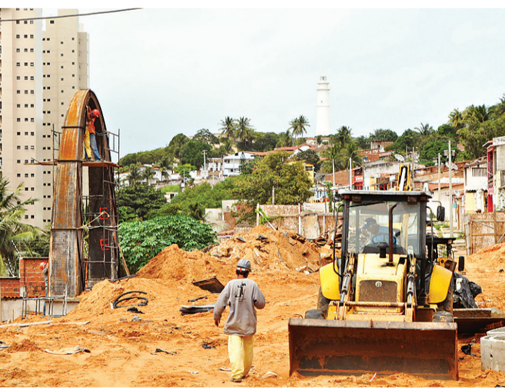
Operários trabalhavam ontem para fechar uma cratera na rua Guanabara
